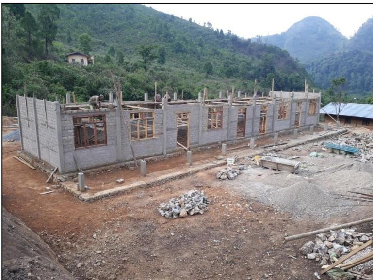
Le père d'Assumpta a dessiné les plans du nouveau bâtiment qui fait 27 mètres de long et 9 mètres de large. Il accueillera 3 salles de classe. Les travaux ont débuté par le nivellement du terrain ainsi que la mise en place des fondations du bâtiment. Les villageois ont préférentiellement utilisé la brique, le bois, un toit fait de plaques de tôle car
